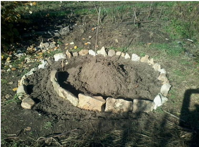
Début de construction de la spirale d'aromates
